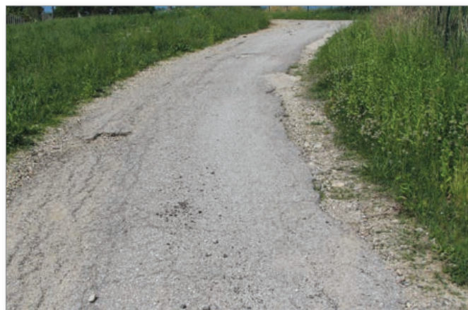
Da je odsek ceste od Pučka v Brengovi proti Vanetini potreben sanacije, priča tale posnetek. In delno jo bo dočakal še letos.
