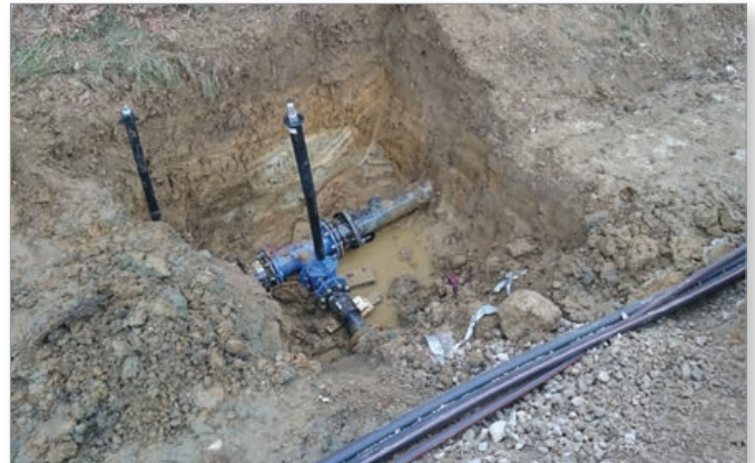
Navezava priključka na glavni cevovod
